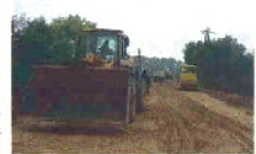
Budowa obwodnicy Jedlińska
