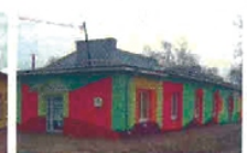
Świetlica w Jankowicach
