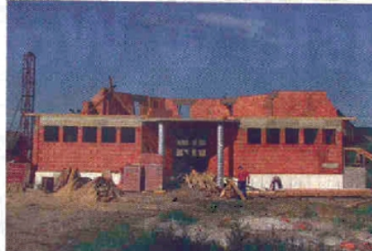
Budowa Ośrodka Zdrowia we Wsoli
