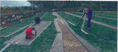
drużyn i trenerów. Koszt budowy to 1.206.580,00zł.
