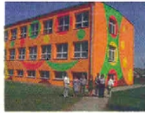
PSP w Jedlance po remoncie - termomodernizacji
