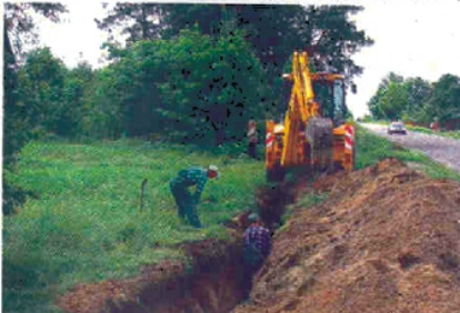
Budowa wodociągu Godzisz
